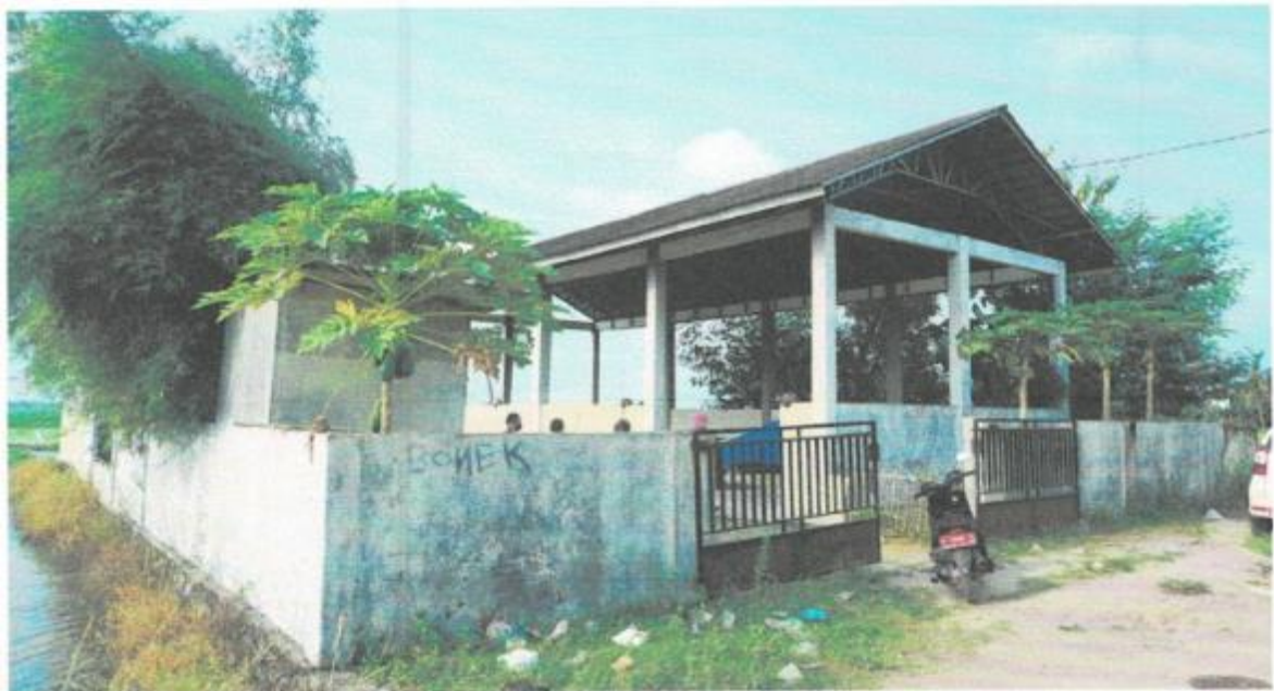
Gambar II.4. Kondisi TPS 3R Kp. Kejaban RT 001 RW 001 Desa Kepandean, Kec. Ciruas Kab. Serang
